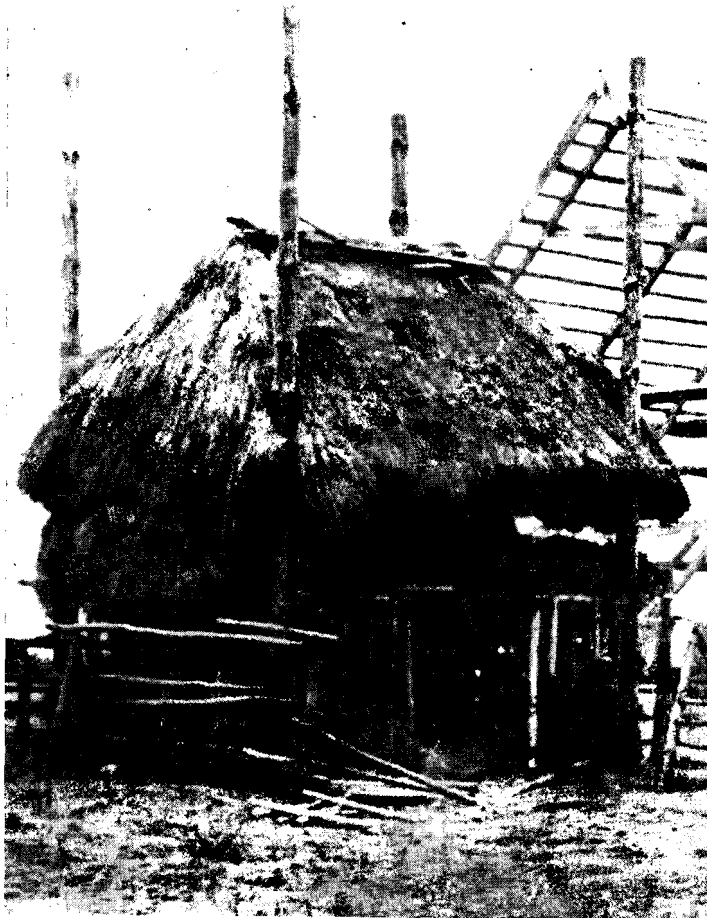
Ryc. 5. Bróg o dachu czterosпадowym, ruchomym; dolna część brogu stanowi rodzaj szopy zaopatrzonej ściankami, a całość jest ogradzona. Wola Solecka, pow. Lipsko
