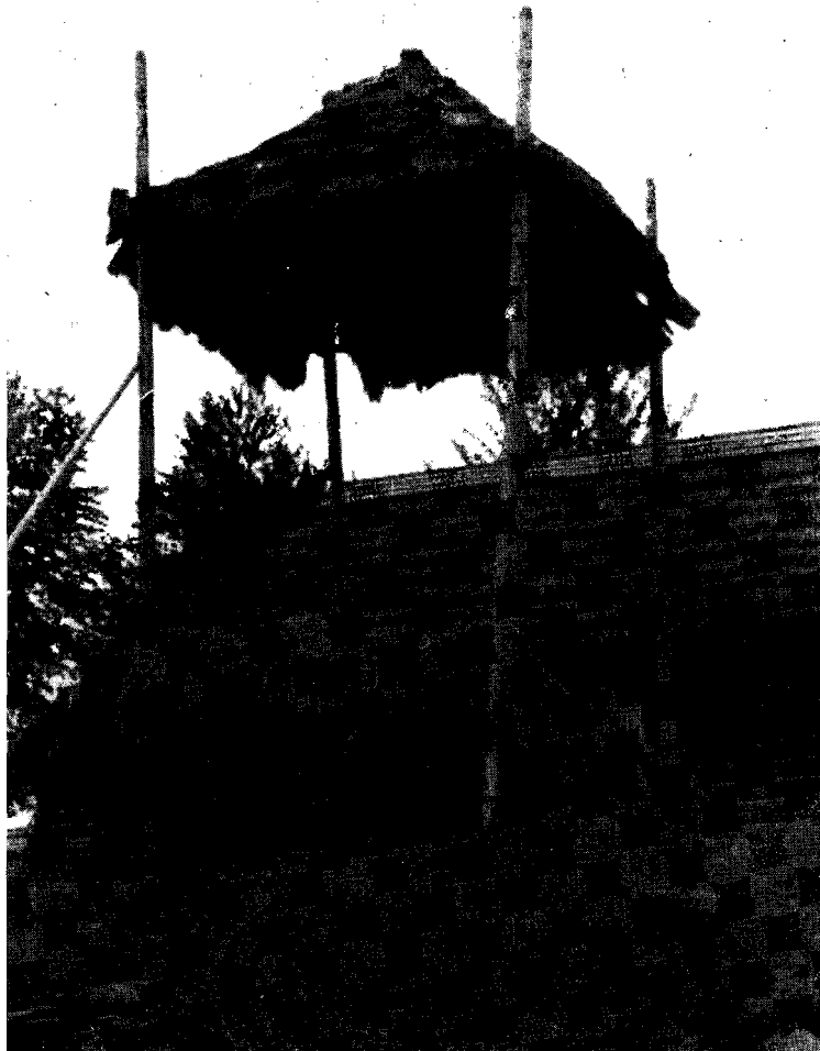
Rys. 1. Bróg o dachu czterospadowym, piramidalnym, ruchomym, zaopatrzony w platformę napalową. Łęki Strzyżowskie, pow. Krosno
