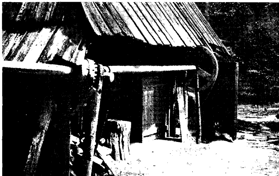
12. Sprzęgło-przekładnia przy Maciasowym foluszu w Łopusznej, osiedle Zarębek Niżny. Widoczne koło pasowe przenoszące energię do rżnięcia siczki, młynkowania itd. Stan ze zdjętym daszkiem, osłaniającym urządzenie
