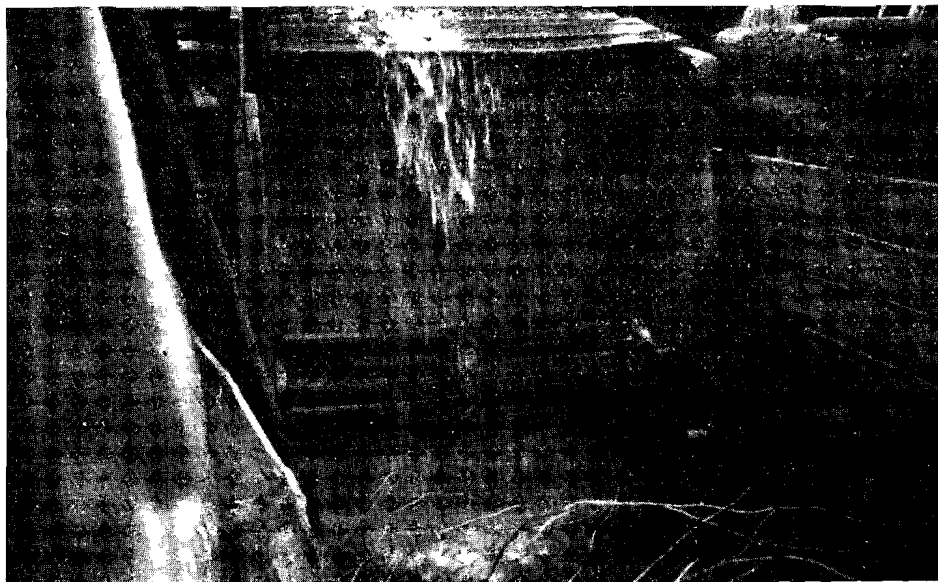
2. Koło wodne wałaska z pionowo spadającą strugą wody. Tartak urbarski w Nowej Białej
