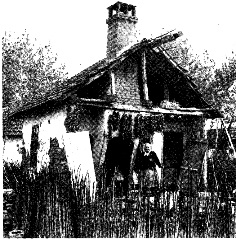
Ryc. 14. Konstrukcja dachu z widocznym odżakiem . Dom w czasie rozbiórki. Tabaszka machała
