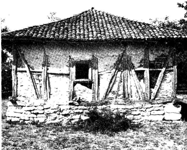
Ryc. 12. Ściana szczytowa kászty z okresu tureckiego (obecnie nie zamieszkanaj) z widoczną pajantową konstrukcją ściany. Nowa machała
