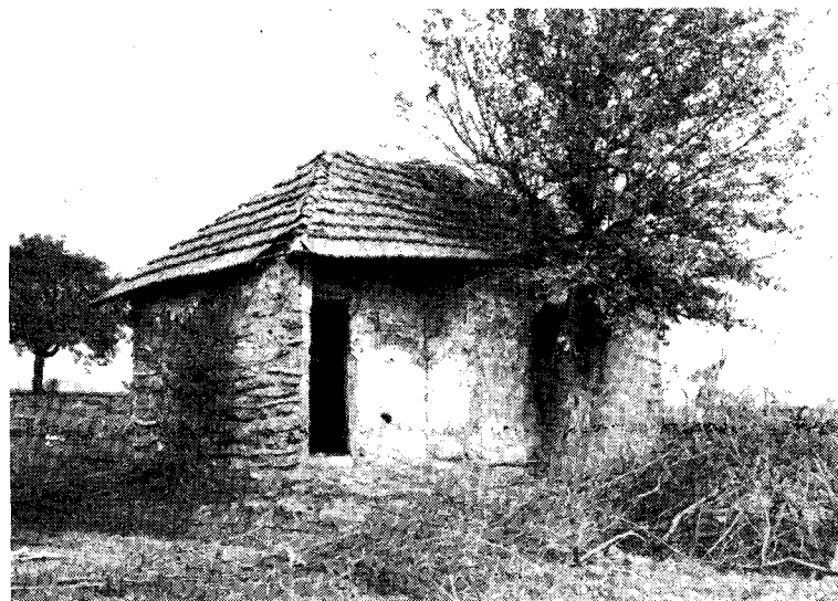
Ryc. 13. Koliba o konstrukcji pajantowej
