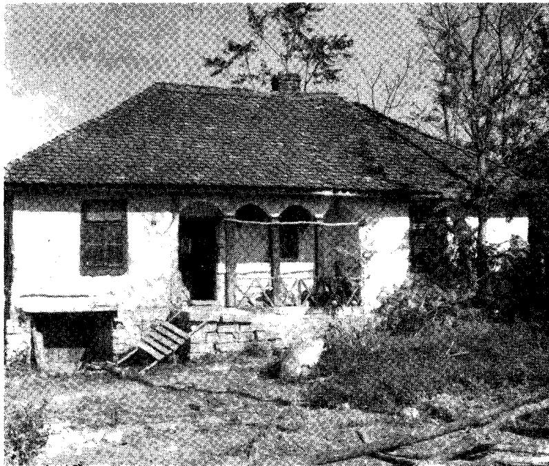
Ryc. 5. Kászta w zagrodzie Anto Czankowa Karadżowa w Mareńskiej machale (Kw. 64). Kászta budowana w 1910 r. i zamieszкана do 1960 r. złożona z odżaku , krewe , dużej soby po prawej stronie odżaku i dwóch małych izb po stronie lewej
