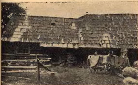
Ryc. 3. Chata z dachem załamany, Biała Woda, pow. Nowy Targ.
