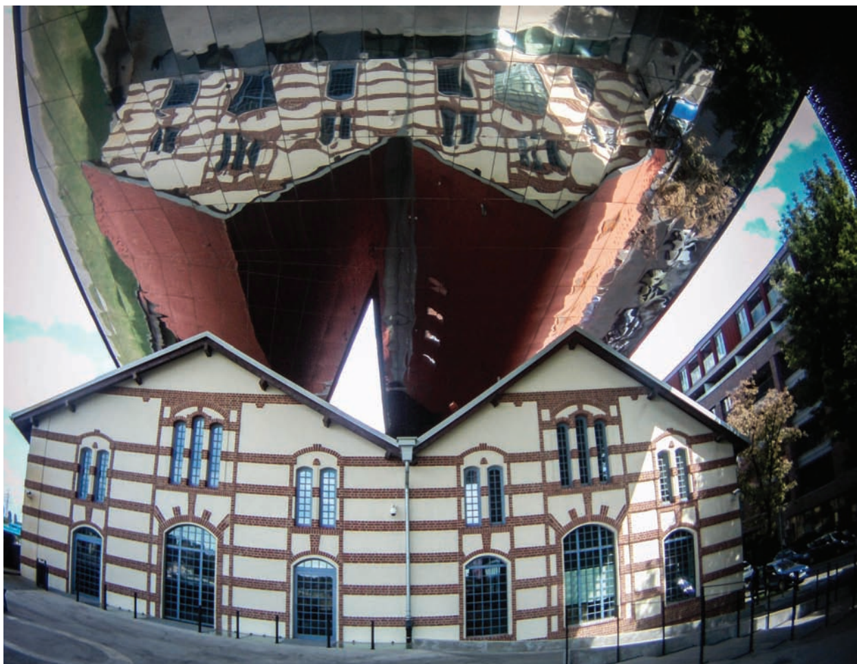
Ulica Nadwiślańska w Krakowie, nowa siedziba Cricoteki. Fot. © Stanisław Barański.
